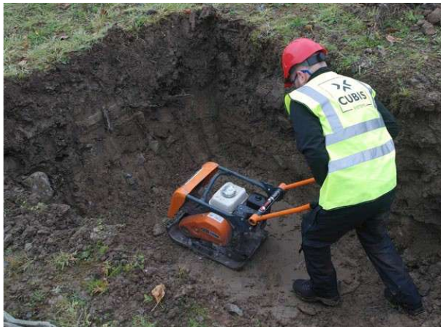
Figur 4 Kompaktering av dräneringsmaterial
