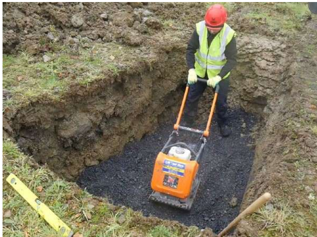
Figur 5 Kompaktering och avjämnning av underlag
