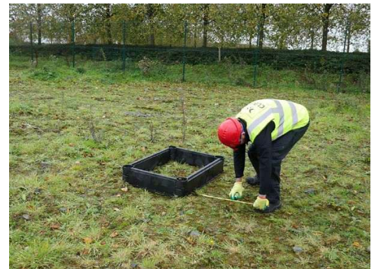
Figur 2 Markering av schaktyta
