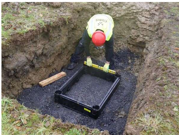
Figur 6 Fortsatt montering av brunnsmodul
