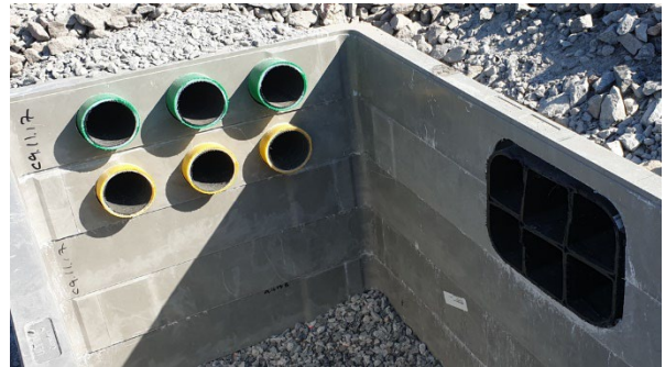
Håltagning i UC sektionssbrunn
