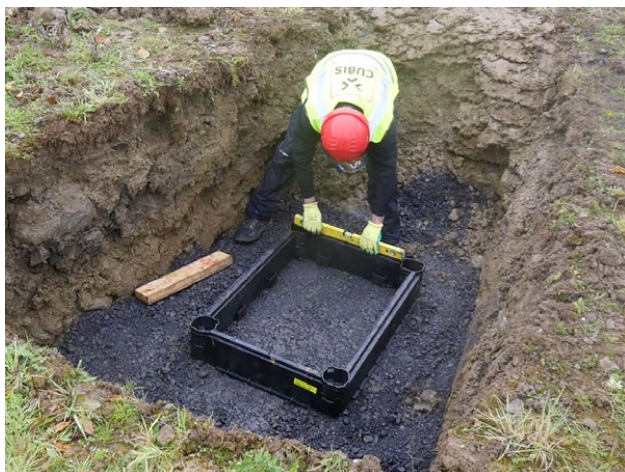
Figur 6 Fortsatt montering av brunnsmodul
