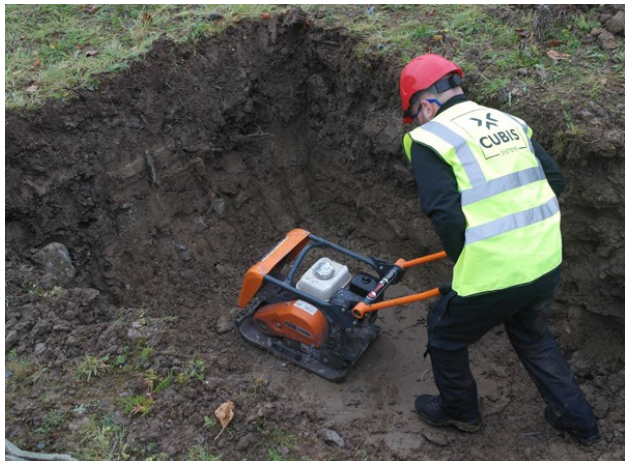
Figur 4 Kompaktering av dräneringsmaterial
