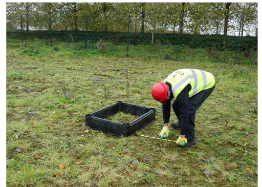
Figur 2 Markering av schaktyta
