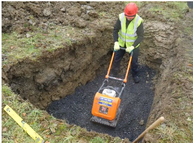
Figur 5 Kompaktering och avjämning av underlag
