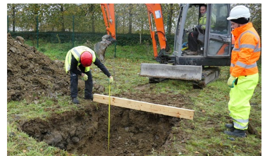
Figur 3 Kontroll av ugrävningsdjup
