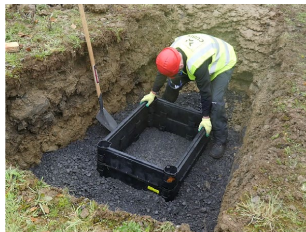
Figur 7 Placering av brunnsmodul
