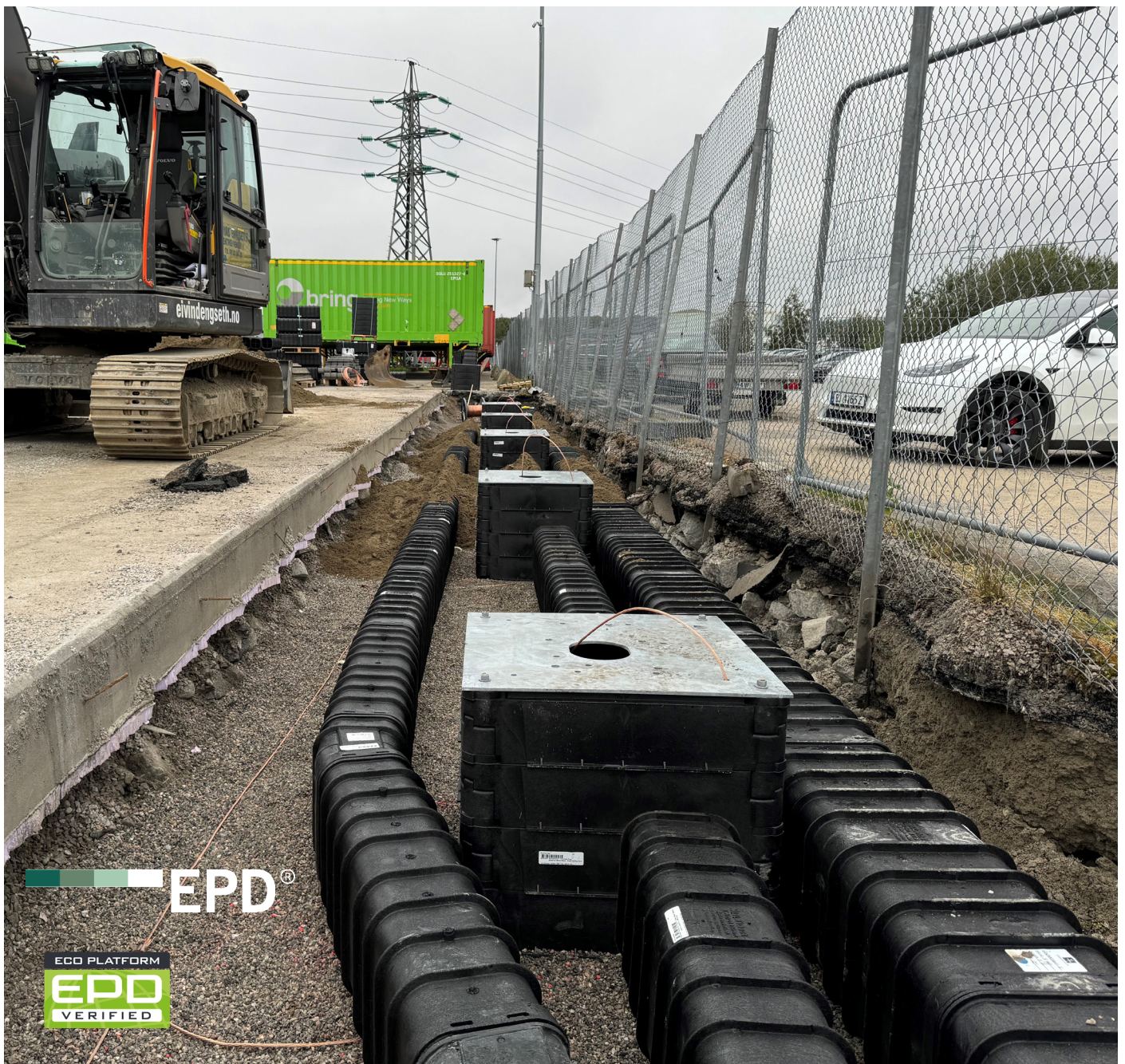
FF-kummer som fundament til ladepunkter og Multikanaler for kabeltrekking.
