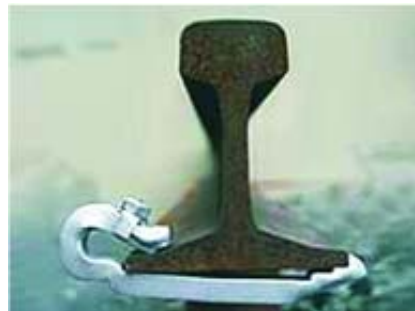
Tverrsnittet gir inntrykk av "spring-fjær" effekten som klemma er basert på
