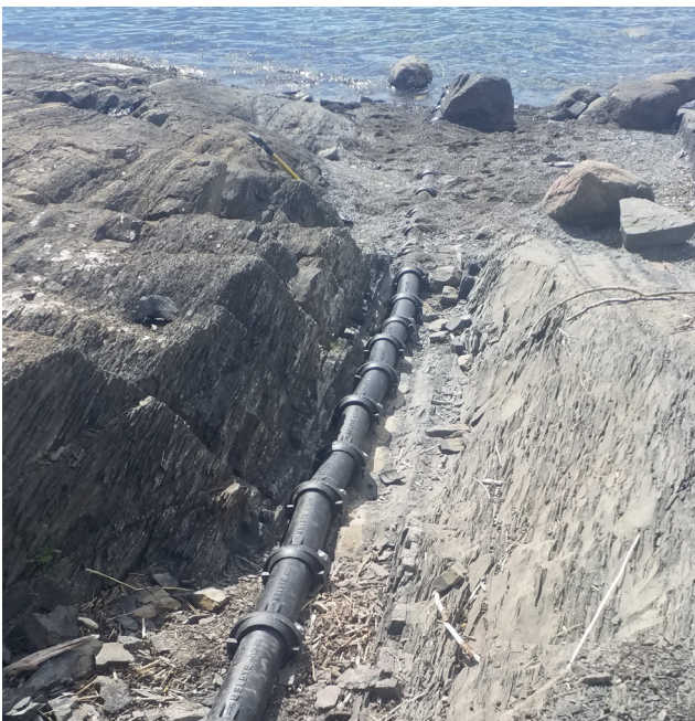
Kabelvernør leveres i lengder a 1 meter. 1 stk består av 4 halvrør som hengsles i hverandre. Rørene låser seg i skjøt og man trenger kun å bolte i ender av røret.
