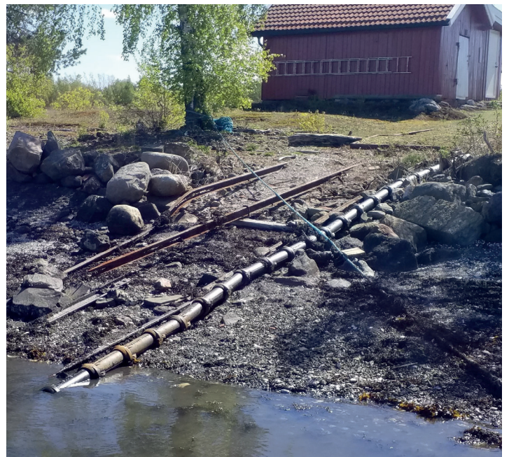
Kabelvernør leveres i lengder a 1 meter. 1 stk består av 4 halvrør som hengsles i hverandre. Rørene låser seg i skjøt og man trenger kun å bolte i ender av røret.
